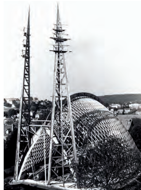
→ L'église, conçue par les frères Sainsaulieu, a été construite de 1964 à 1966.
