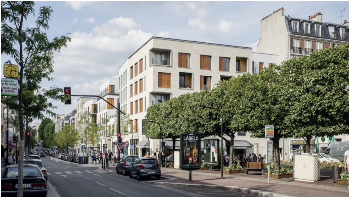
Logements en accession et sociaux à Bourg-la-Reine (92), Badia Berger Architectes & promoteur Emerige.
