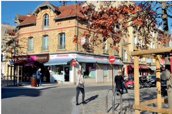
Immeuble d'habitation en meulière dans le centre ville
