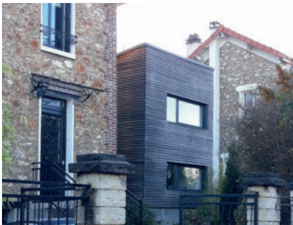
Extension d'une maison individuelle en bois à Viroflay
