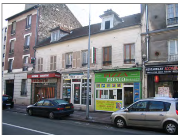
Commerce en pied d'immeuble
