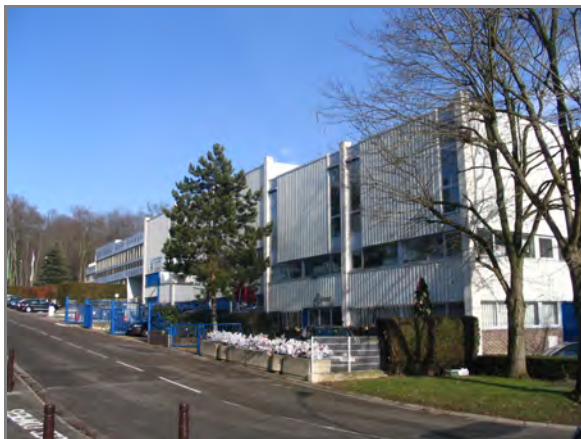
Bâtiments de la ZAE de la Pépinière
