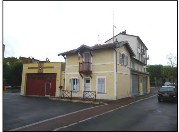
Caserne des Pompiers
