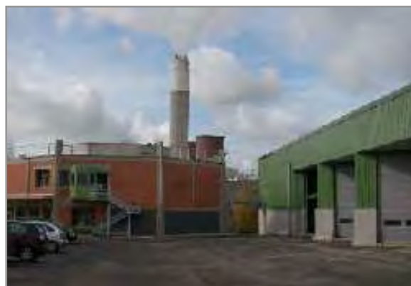
Centre de tri de Thiverval (Source : site Internet du SIDOMPE)
