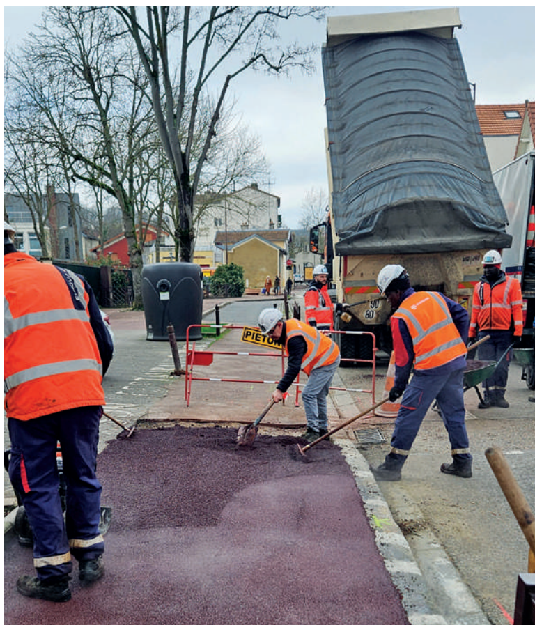
→ Travaux d'enrobé à chaud.
