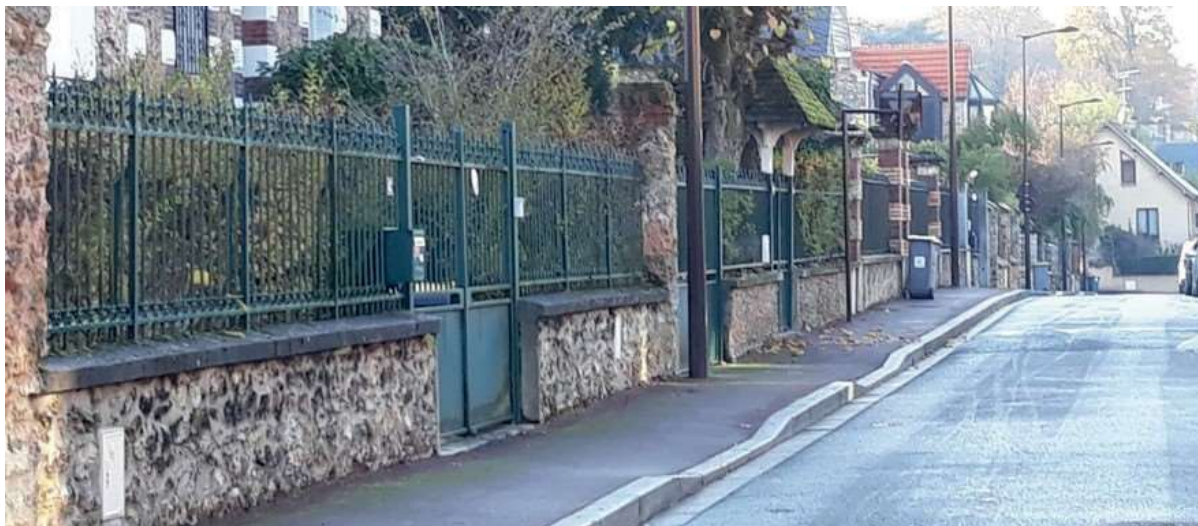
Murs bahuts à Viroflay © D. Touiller
