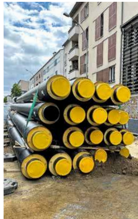
© Sigef - Travaux géothermie à Chaville
